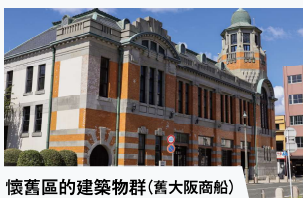
懷舊區的建築物群(舊大阪商船)
